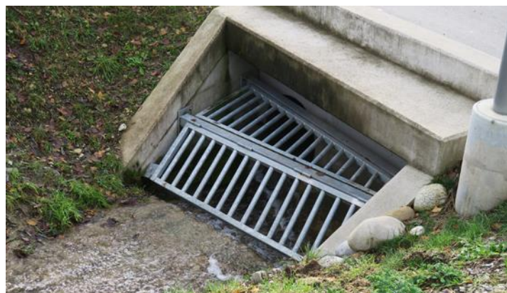
Einlaufschacht mit Geschiebe-Rechen an der Badenerstrasse. 15.12.2023
