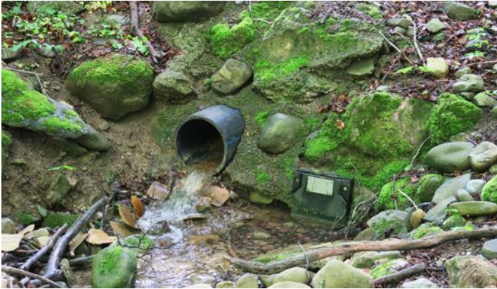
Einlaufrohr zum Schluckgraben.
