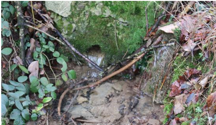
Austritt aus der Drainage Nord am oberen Waldrand. 15.12.2023
