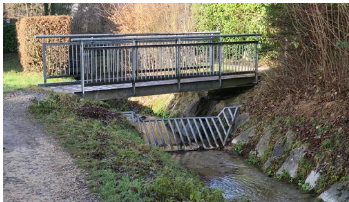
Fussgängerbrücke und Geschieberechen. 27.12.2023
