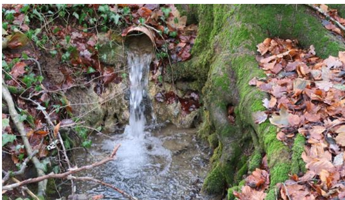
Austritt aus der Drainage Süd am oberen Waldrand. 15.12.2023
