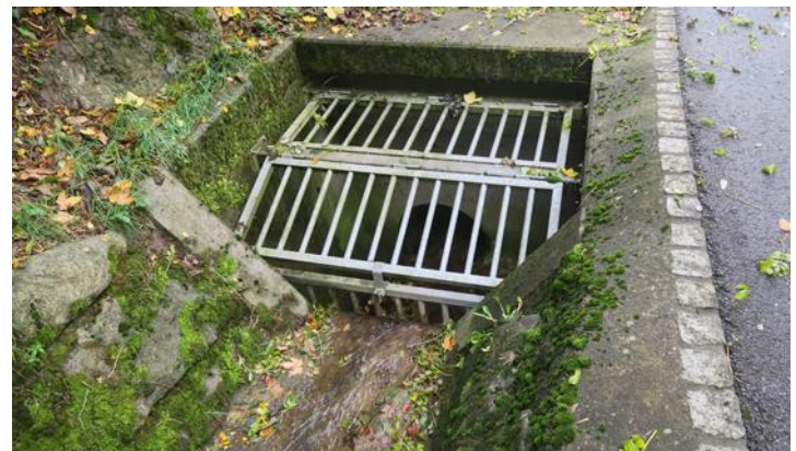
Einlaufschacht zur Dolung vom Ifang zur Badenerstrasse. 25.10.23
