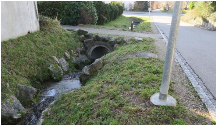
Fussweg zu der Wohnsiedlung über den Bach. Das Ufer ist mit Blocksteinen gesichert. 27.12.2023
