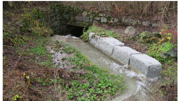
Einlauf zur Dolung an der Oberen Grabenmattstrasse. Das Prallufer ist mit Blocksteinen gesichert. Am Gleitufer wachsen Wasserpflanzen in den Sedimentablagerungen. 15.12.2023
