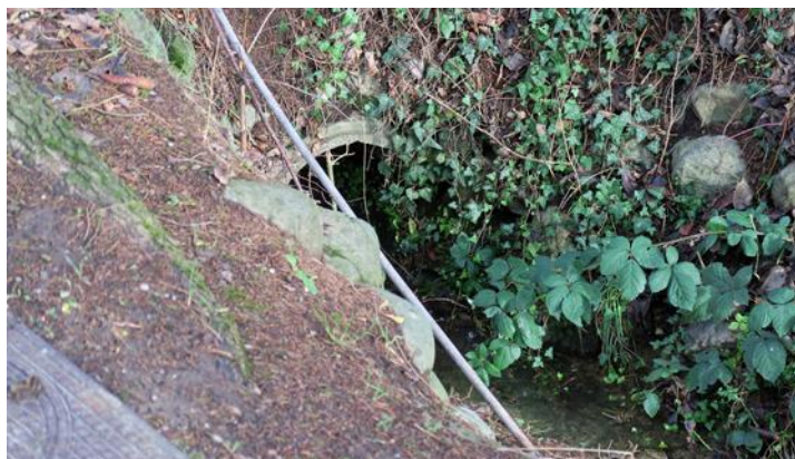
Einlaufrohr von der Obermatte herkommend.
