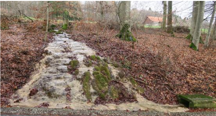
Kalktuffgebilde an der Bergstrasse und Einlaufschacht (rechts unten). 15.12.2023
