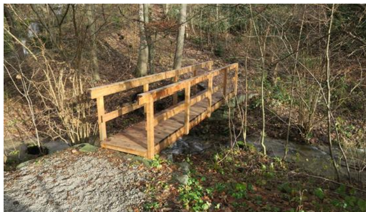
Brücke über den Oberzelgbach. Verbindungsweg zwischen Hofmatt und Bademerstrasse. 15.12.2023
