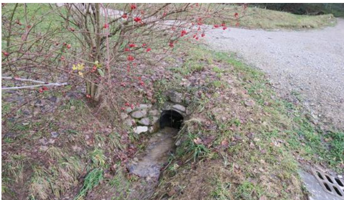
Unterquerung beim Weg zum Materialdepot (2'667'181/1'252'616) 15.12.2023
