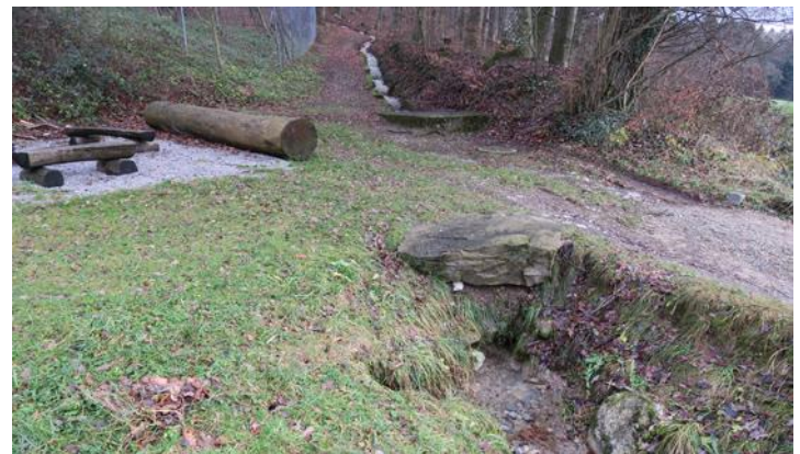
Unterquerung des Weges und Zuleitung aus dem Weiher. 15.12.2023
