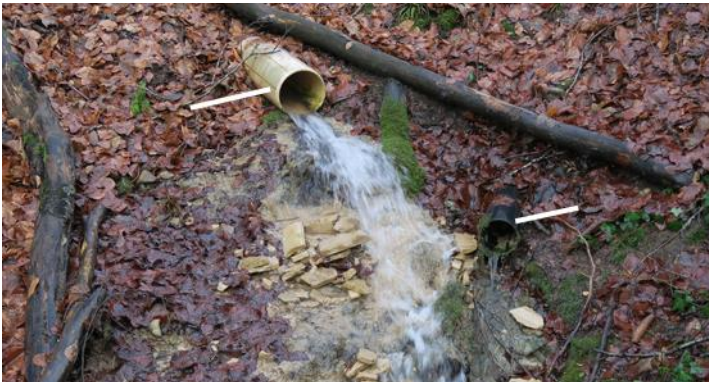
Zufluss-Drainagerohre unterhalb der letzten Kurve der Bergstrasse. Hier beginnt der offene Lauf des nördlichen Waldbächleins. 15.12.2023
