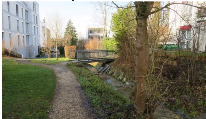
Mülibachweg und Fussgängerbrücke und Geschieberechen kurz vor der Dolung nach Niederrohrdorf. 27.12.2023
