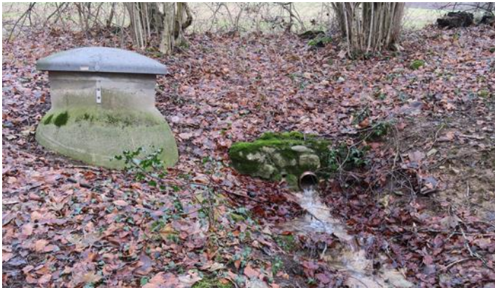
Schacht mit Abdeckung. Rechts daneben Drainagerohr. 15.12.2023
