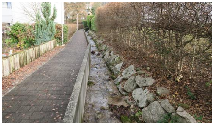
Abschnitt Steigässli mit Blockstein-Böschung und Hagebuchen-Hecke. 15.12.2023
