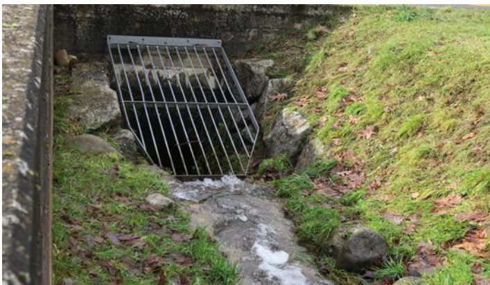
Einlaufschacht mit Geschieberechen an der Hinterbächlistrassen. 15.12.2023
