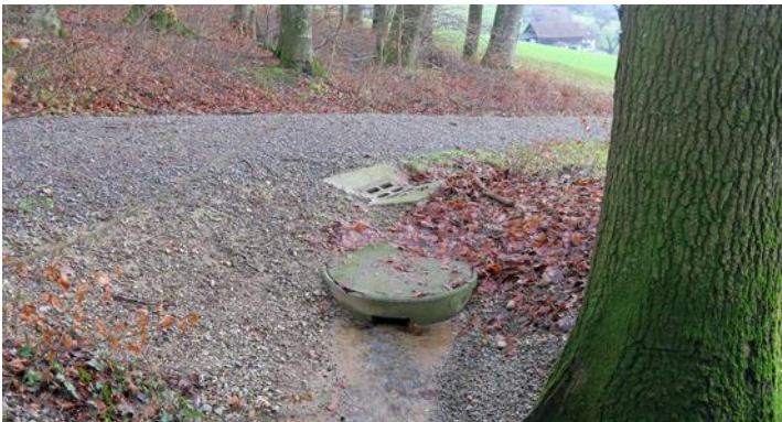
Überlauf vom Weiher zur Dole am nördlich gelegenen Wegrand. Am anderen Wegrand befindet sich ein weiterer Dolenschacht wo beide Bächlein zusammenfließen und unterirdisch zum Ifang fließen. 15.12.2023
