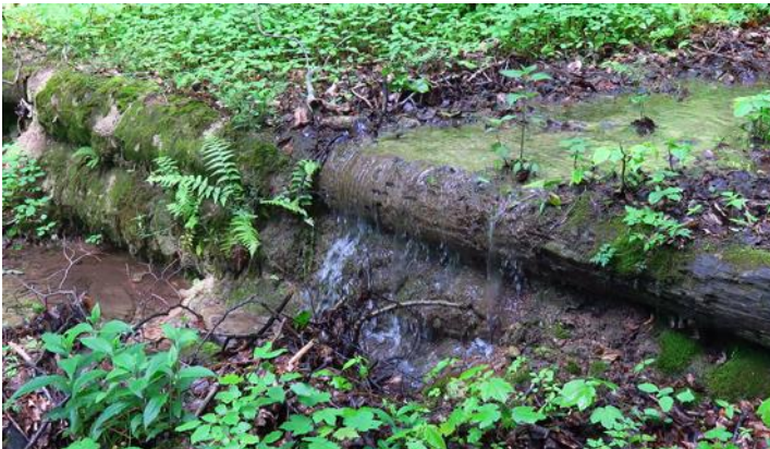
Bachverbauung mit Holzschwellen.
